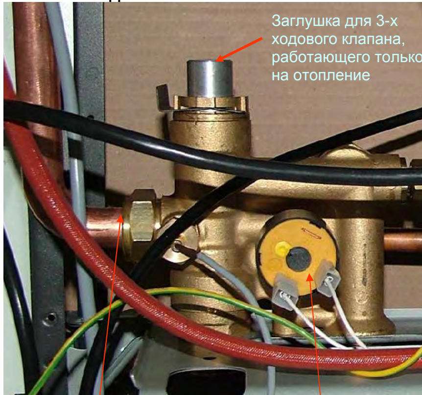
Подсоединение трубы подачи
